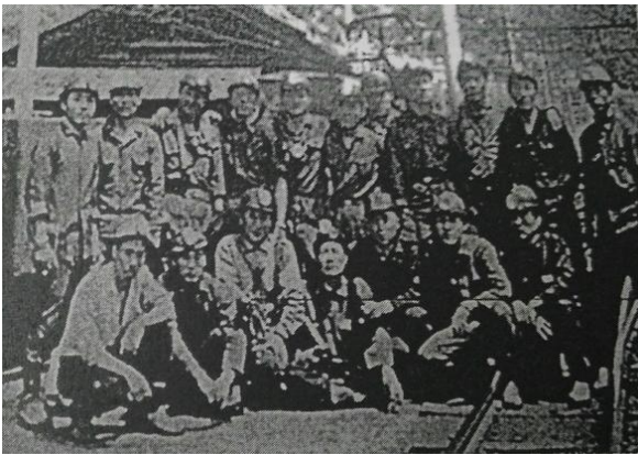
عمال المناجم الكوريين في ألمانيا القاعة التذكارية لعمال المناجم
