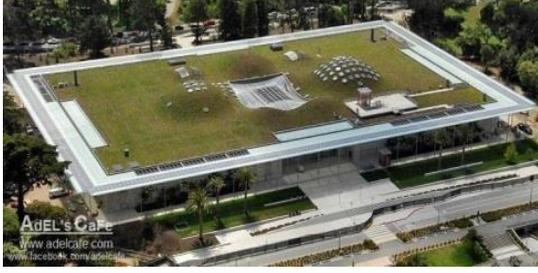
يبدو كقطعة من حديقة وتبلغ مساحته ( 2.5 فدان امريكي اي حوالي 10115 م<sup>2</sup> ) لزراعة النباتات ويقوم هذا السطح باستيعاب من 90-98% من مياه الأمطار والتي يستفاد منها في ري النباتات وشرب الكائنات الحية داخل المشروع كما توجد خلايا ضوئية في سطح المبنى والتي تقوم بتوفير 6 KW من الطاقة الكهربائية من الطاقة الشمسية وهذه الكمية تكفي لتغطية
